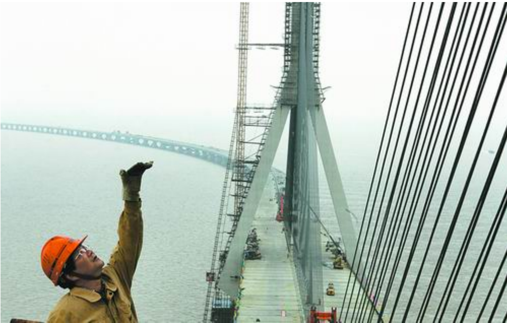
海大桥主通行孔的主塔。东方早报记者 许海峰 图
