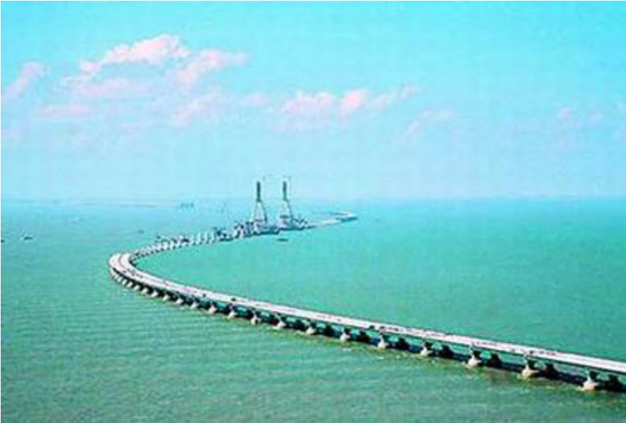
资料图片：已架设了 500 块桥面板的东海大桥，雄姿已现。徐存福傅国林摄（东方网-文汇报）
